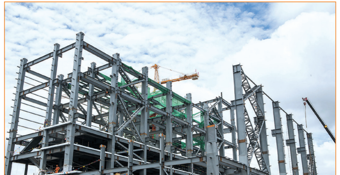
LẮP DỰNG KẾT CẤU THÉP
